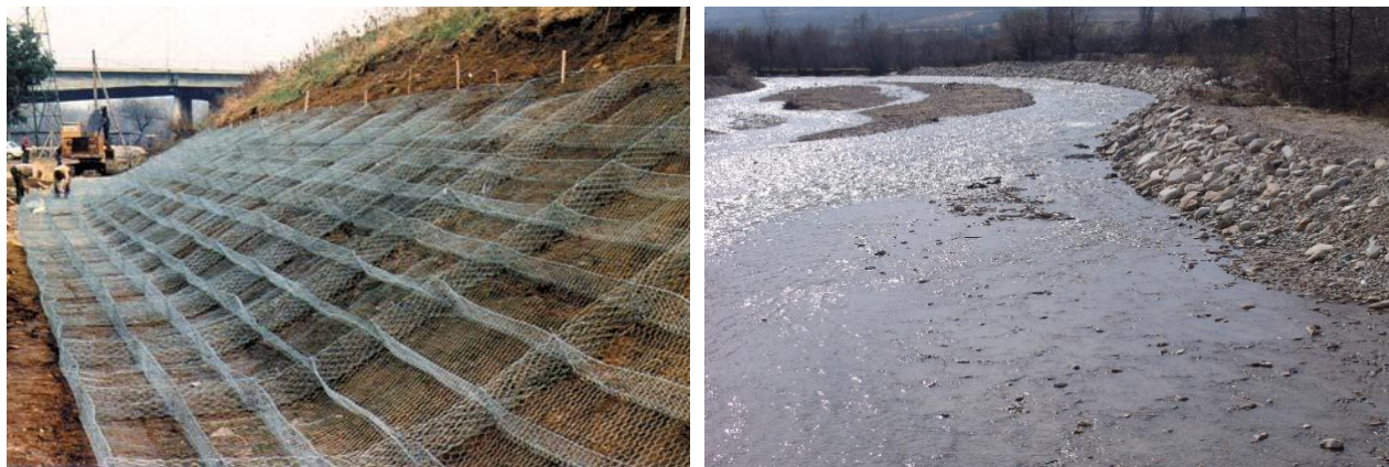
Ábra 14. Stabilizációs megoldások a bankok számára: balra: a gabion matrac modellje, amely készen áll a sziklafű (Arrigo Gabioni Inc) fogadására; Jobb: a rockfalls használata egyes bankok védelmére.
